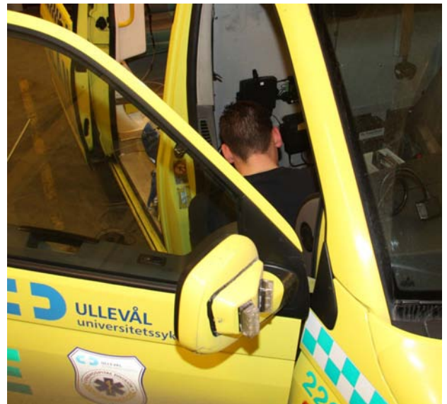
To betjeningspanel monteres, ett i førerkupé og ett i sykekupéen av montører fra Ferno Norden.
